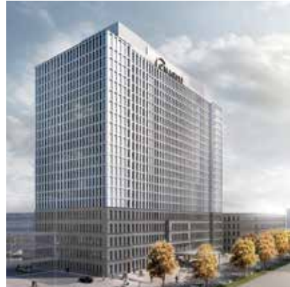
Bettenhochhaus, Ansicht Luisenstraße
